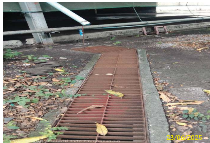
รางระบายน้ำจากพื้นที่กองถ่านหิน
