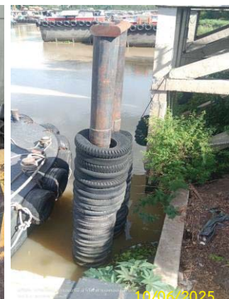
ติดตั้งหลักผูกเรือ และยางกันกระแทกเรือบริเวณท่าเรือ
