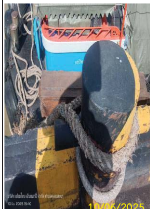
ติดตั้งหลักผูกเรือ และยางกันกระแทกเรือบริเวณท่าเรือ
